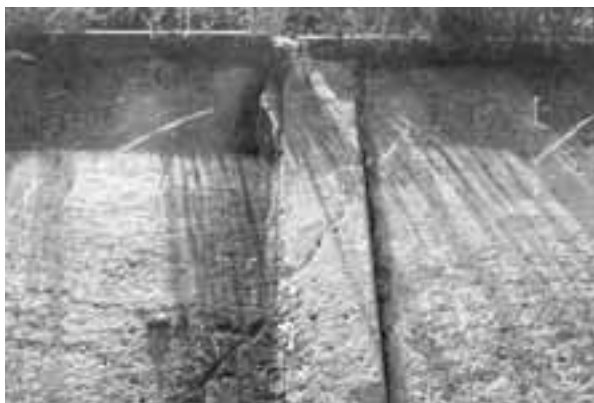
図4 山形市緑町1丁目の馬見ヶ崎川左岸にみられる巨礫の躍動による護岸コンクリートの傷からは、直径数十cm以上の巨礫が躍動で運ばれていることがわかる。
