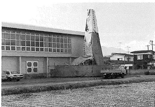
写真-1 金井小学校における地質調査ボーリング
