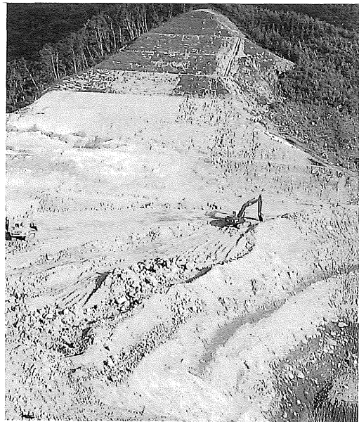
写真-1 法面が仕上げられながら下方への掘削が進行していた一時期(東側法面, 1989年8月)
