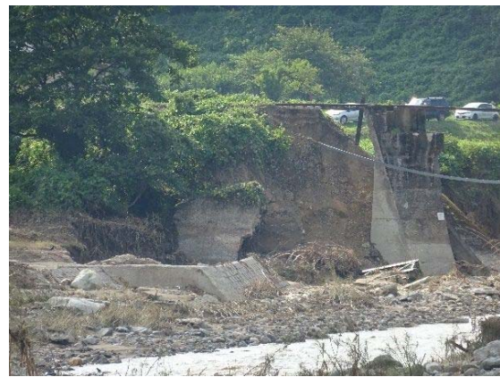
図 24. JR 米坂線，小白川橋梁倒壊箇所状況（下流側より） 図右は右岸橋台部の拡大 ※攻撃斜面側（右岸側）の洗掘は下流側で顕著であるが，左岸側の橋脚に顕著な損傷はみられない
