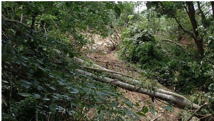
図 35. 土石流の痕跡が残る斜面（上流側） 斜面上方を望む ※斜面上方には，円礫を多量に含む地層（段丘堆積物）の分布が確認される
