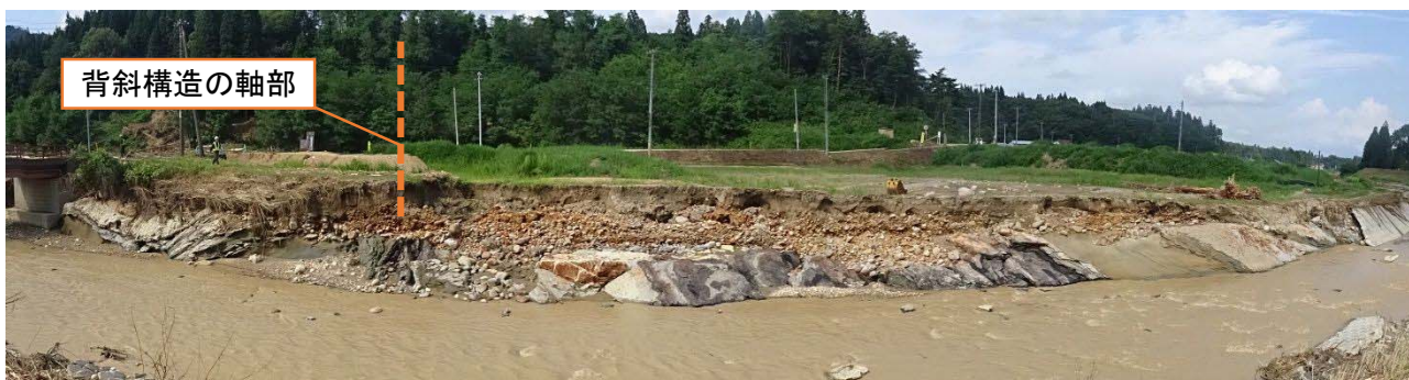
図 39. 竹原橋周辺の状況（下流側） ※右岸側の損傷が少ないのに対し、左岸側は護岸工が流出し基盤岩が露出する（図下は災害前の Google Map のストリートビュー）
