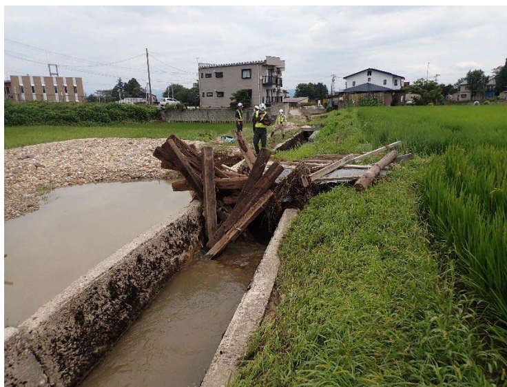
図 13. 水路の閉塞状況（流木は人工の資材が多い）
