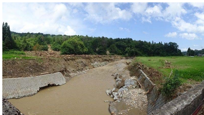
図 29. 北向橋下流側の状況（左岸側の護岸はほぼ流出） ※左岸側から土石流に伴う流木の痕跡が確認される
