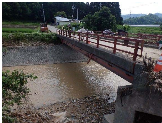
図 37. 竹原橋の状況（橋梁への流木、土砂堆積は僅かに確認される程度）
