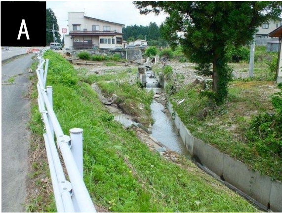
図 18. 調査箇所下流側の越水箇所（左岸側に土砂が流出している）
