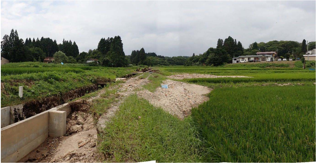
図 11. 水路沿いの越流箇所（円礫～亜円礫主体の砂礫が水田に流出・堆積）
