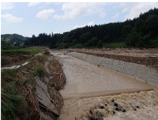
図 38. 竹原橋周辺の状況（上流側） ※護岸を含め損傷は限定的である
