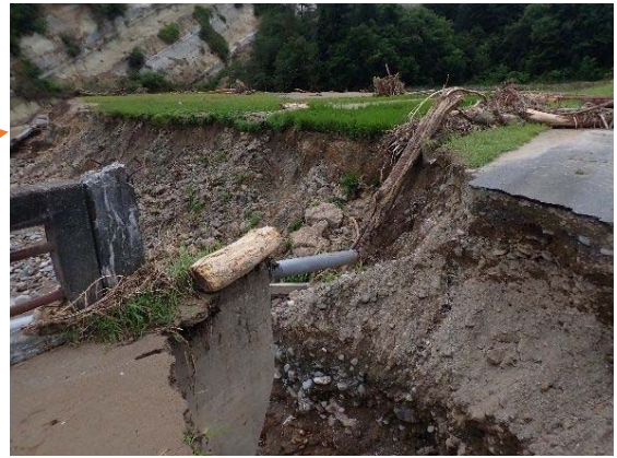
図 28. 北向橋上流側の状況 ※右岸側は基盤岩，左岸側は二次堆積物が露出している。特に橋の右岸上流側で洗掘が顕著
