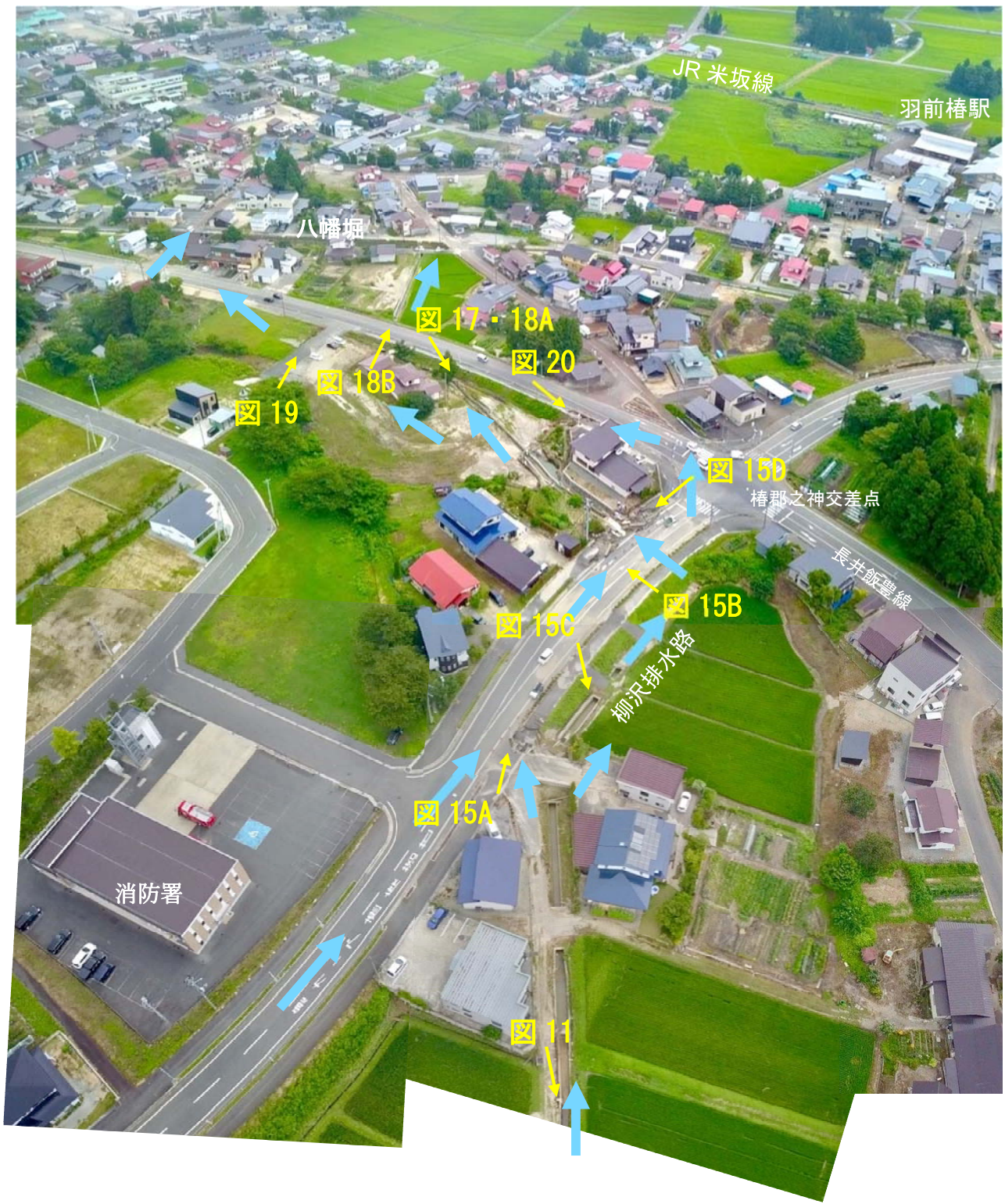
図9. 柳沢排水路の変状. 消防署付近から東方を望む (8月7日11:00頃空撮)
