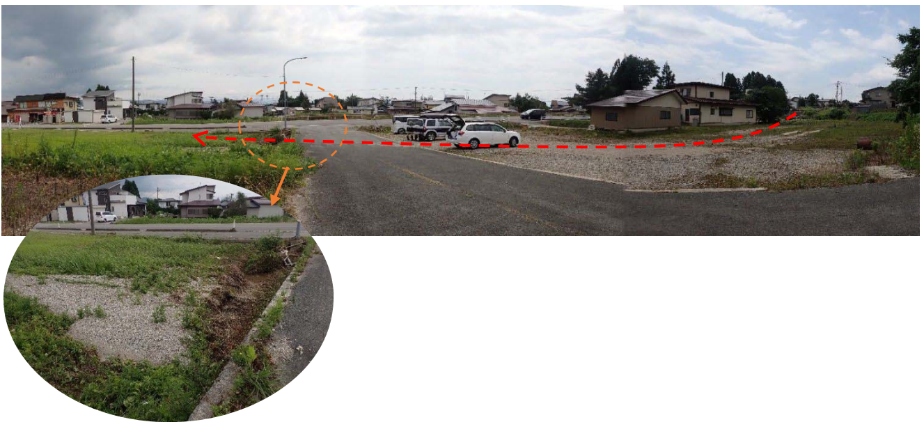
図 19. 調査地下流側の越水状況（旧河道沿いを流下）
