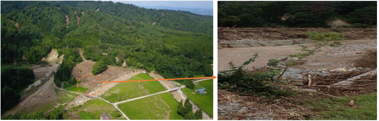
図 30. 北向橋左岸で発生した土石流の痕跡（多量の流木が残されている） ※上流側に複数の洗掘の痕跡が認められる
