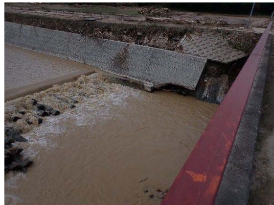
図 38. 竹原橋周辺の状況（上流側） ※護岸を含め損傷は限定的である
