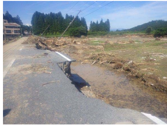
図 23. 落橋した大巻橋（左）及び県道越水部下流側の洗掘（右）（写真提供：中央開発 岩田 賢. 8月6日撮影）
