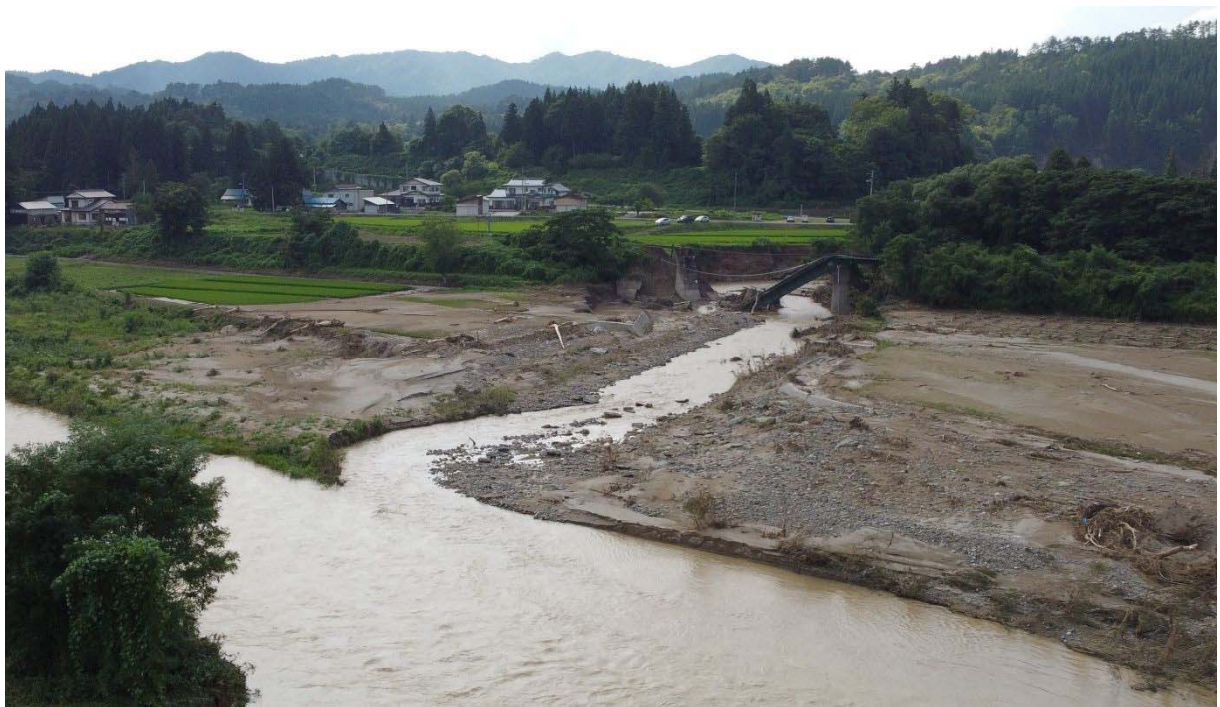
図 25. JR 米坂線，小白川橋梁倒壊箇所状況（全景下流側より）
