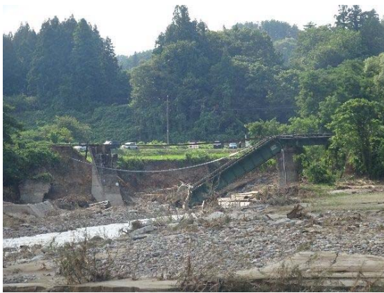
図 24. JR 米坂線，小白川橋梁倒壊箇所状況（下流側より） 図右は右岸橋台部の拡大 ※攻撃斜面側（右岸側）の洗掘は下流側で顕著であるが，左岸側の橋脚に顕著な損傷はみられない
