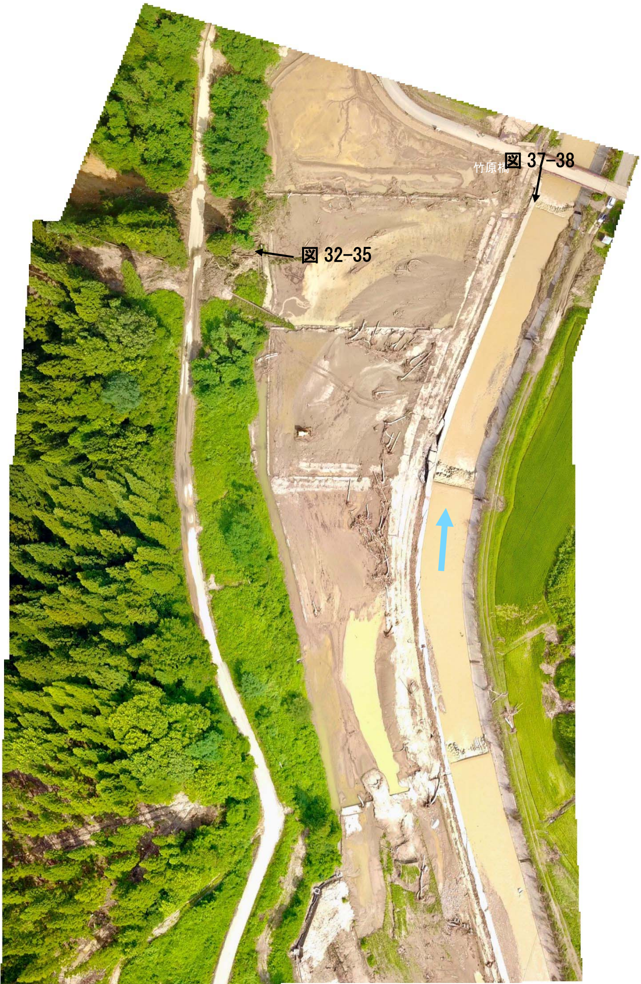
図 36. 竹原橋の上流側 (8月7日 14:30 頃空撮)
