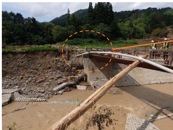
図 28. 北向橋上流側の状況 ※右岸側は基盤岩，左岸側は二次堆積物が露出している。特に橋の右岸上流側で洗掘が顕著
