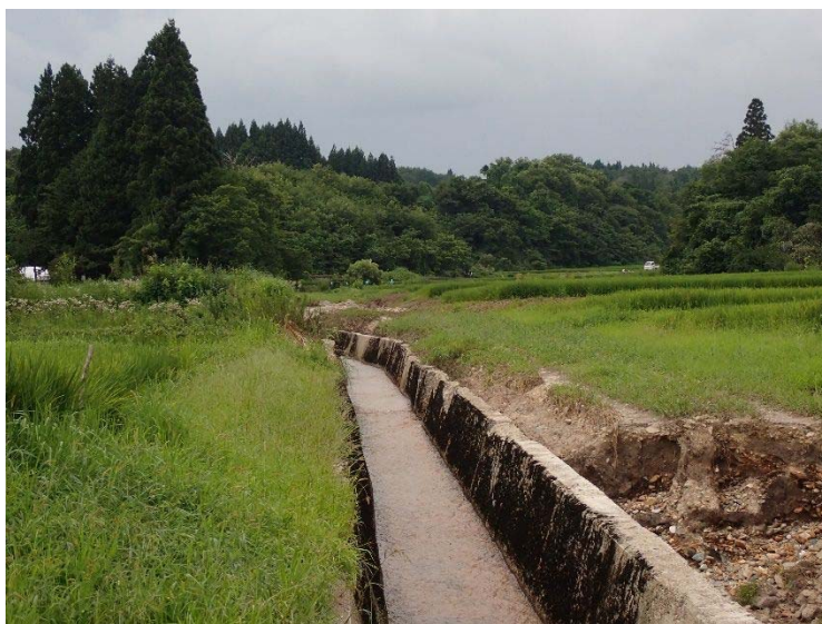
図7. 調査地より上流側を望む。コンクリート張りの水路脇（特に左岸）の洗掘が顕著だが、周辺の被害は比較的少ない
