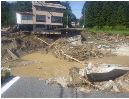
図 23. 落橋した大巻橋（左）及び県道越水部下流側の洗掘（右）（写真提供：中央開発 岩田 賢. 8月6日撮影）
