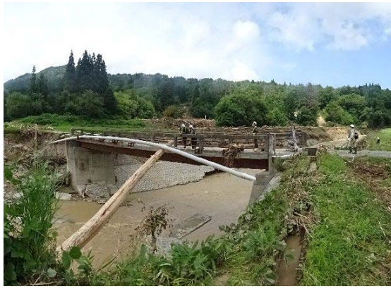
図 27. 北向橋の状況 ※橋桁には流木の痕跡が残されている
