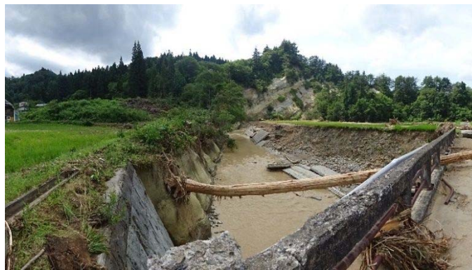
図 27. 北向橋の状況 ※橋桁には流木の痕跡が残されている
