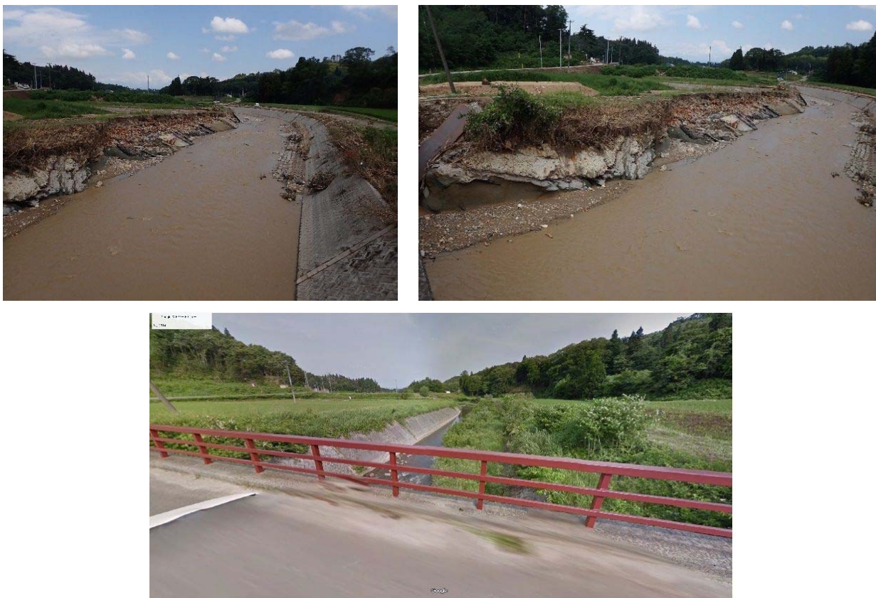
図 39. 竹原橋周辺の状況（下流側） ※右岸側の損傷が少ないのに対し、左岸側は護岸工が流出し基盤岩が露出する（図下は災害前の Google Map のストリートビュー）
