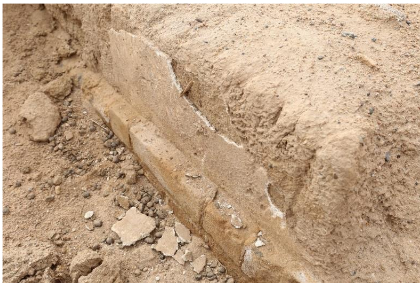
Fig. 5-7 Шувуутайн хийд Ш5-ны шохойгоор будагласан шавар хана.
