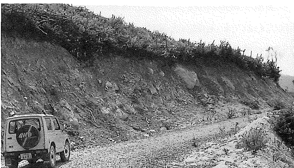
第11図 留山川砂防ダム上流の地すべり地内の崩壊土塊 硬質な凝灰岩の礫を交えている
