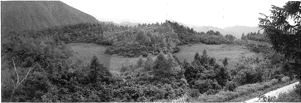
第5図 ムクロ沢地すべりの滑落土塊の冠頭亀裂を埋める湿地堆積物
