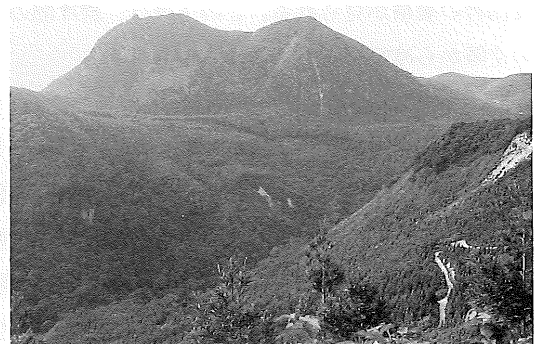
第8図 黒伏山とその南方の地すべり斜面 崩壊土塊は野川の下刻によって再崩壊している
