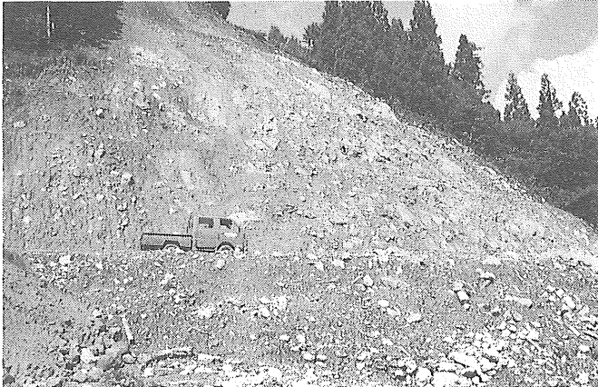
写真-2 白鷹大崩壊地内の土塊は成層構造をもたない(畑谷から築沢に至る間にて)
