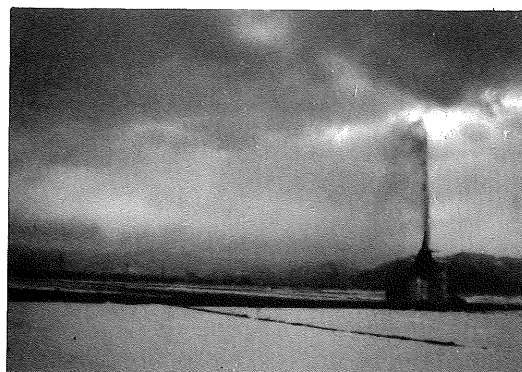
第7図 寺津地点(地表下34m層準)におけるガスの噴出状況
