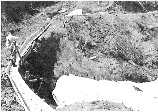
写真-1 上平丸地すべりの尾根部を越して反対側の斜面まで拡大した地すべりの頭部
