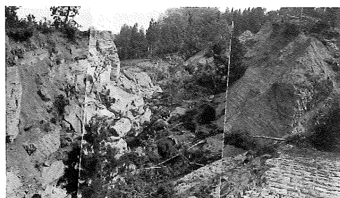
写真-3 黑色泥岩の斜面での初生すべり (新潟県東頸城郡大島村嶺地内, 1965年5月)
