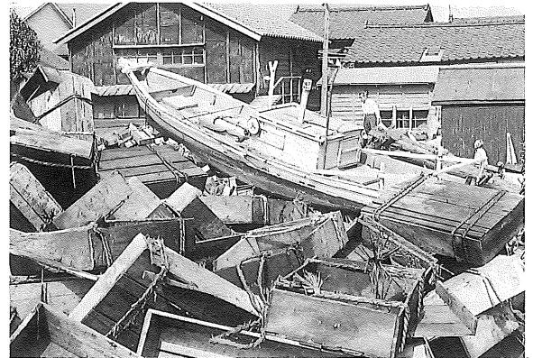
写真-6 津波により道路に打ち上げられた漁船
