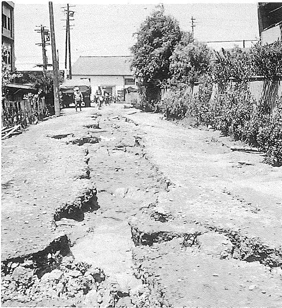
写真-10 地割れによって拡幅された道路
