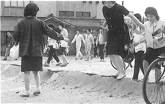
写真-3 圧縮されて盛り上がった路面
