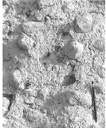
写真-7 小松原台地を広く覆う「雑色凝灰角礫崩れ」(Z)の堆積状況
