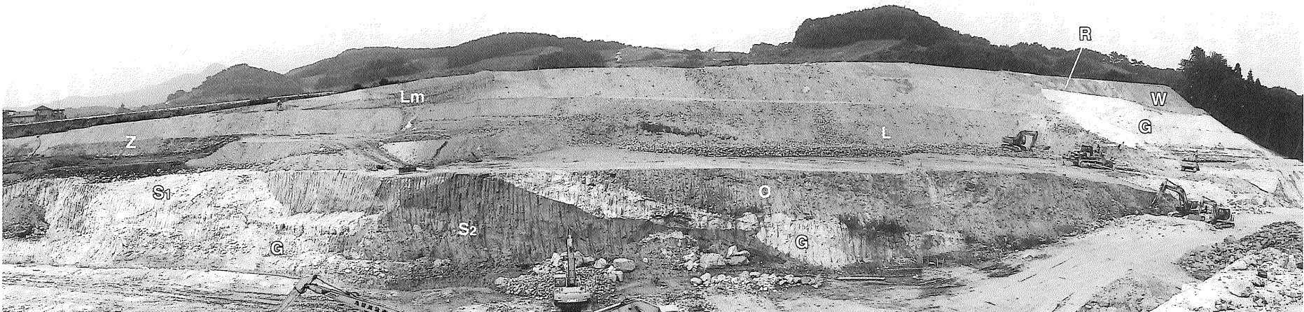
写真-3 「北東大露頭」西側法面の露頭最下位は現地性の基盤岩である浮石質凝灰岩（菅沢層下部，S 1 ）がわずかに露出している。基盤の上部にブロック化した茶白色凝灰質砂岩（菅沢層下部，S 2 ）が接している。さらに上位を「グリーン崩れ」（G）、「オレンジ崩れ」（O）が覆うがこれらをシャープに切って「溶岩崩れ」（L）がのる。さらに上位を「赤タフ崩れ」（R）、「風化礫崩れ」（W）がおおふ。露頭の背後の台地（元は起伏のある丘陵）ではグリーン崩れが広く覆い、その上位を部分的に「赤タフ崩れ」が覆い、その上部を「風化礫崩れ」が広く覆っていた（写真-6）参照。露頭左（南）側は「雑色凝灰角礫崩れ」（Z）が覆うが、この岩質の岩体（新規崩壊堆積物群）はこれより南2kmほど連続する。最上部は現地性のローム質層（Lm）が覆う。
