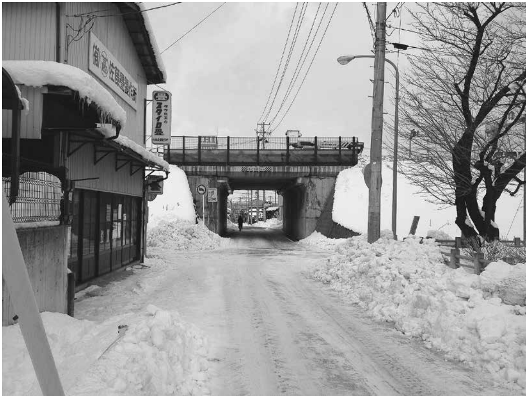
写真1 国道13号線の冬季の高架下道路
