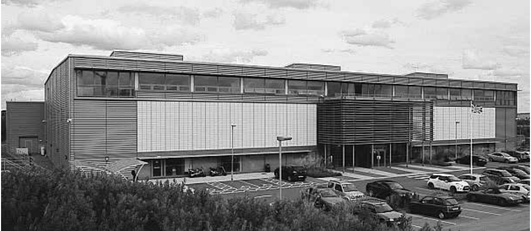
写真1 ロールス・ロイス未来工場の全景 (出所) AMRCウェブサイト
